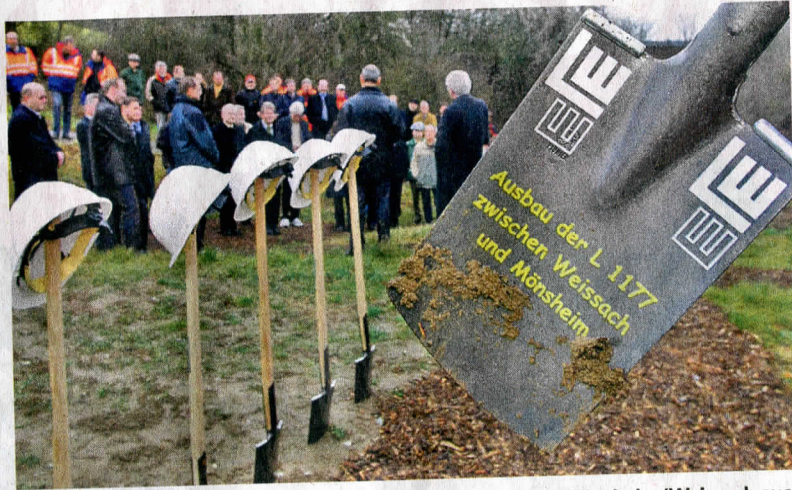
Gute Straßen für Porsche: 2008 wurde die marode Strecke Mönshheim/Weissach ausgebaut. Nun soll eine weitere Zufahrt zu Porsche saniert werden. FOTO: SEIBEL, ARCHIV
